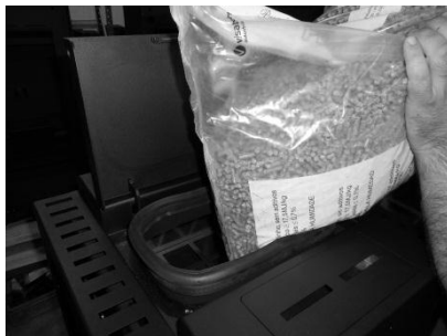
Figura 25 - Reabastecimiento del depósito de pellets
