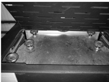
Figura 30 - Limpeza dos turbuladores
