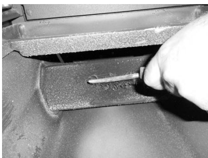
Figura 31 - Limpeza do interior da salamandra a água
