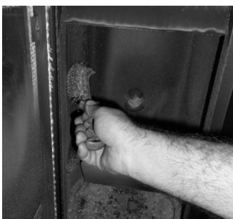
Figura 31 - Limpeza do interior da salamandra a água
