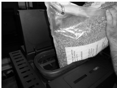
Figura 25 - Reabastecimento do depósito de pellets
