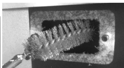
Figura 142 – Ejemplo K300, K400 a) Aspirar el interior; b) Limpiar con escobillón
