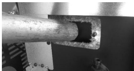
Figure 142 – Exemple K300 et K400 a) Aspirez l'intérieur ; b) Nettoyez avec un écouvillon
