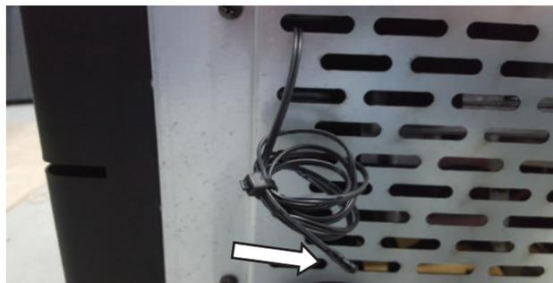
**Figura 9 - Sonda de temperatura ambiente**
