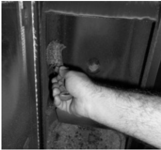
Figura 34 - Limpieza del interior de la estufa de agua
