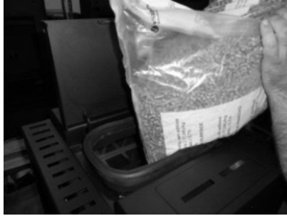
Figura 25 - Reabastecimiento del depósito de pellets
