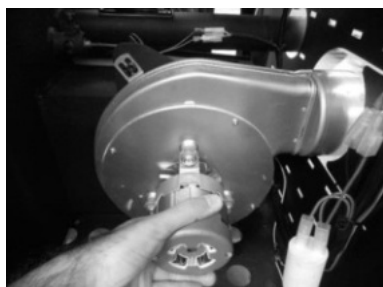
Figura 42 - a) Retirar los tornillos; b) Retirar el extractor
