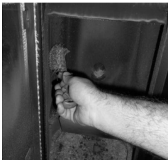
Figura 47 - Limpeza do interior da salamandra a água
