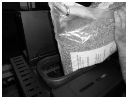
Figura 41 - Reabastecimento do depósito de pellets
