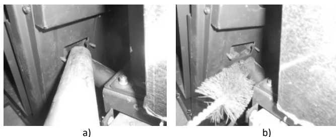
Figure 109 – a) Aspirer l'intérieur b) Nettoyage avec brosses
