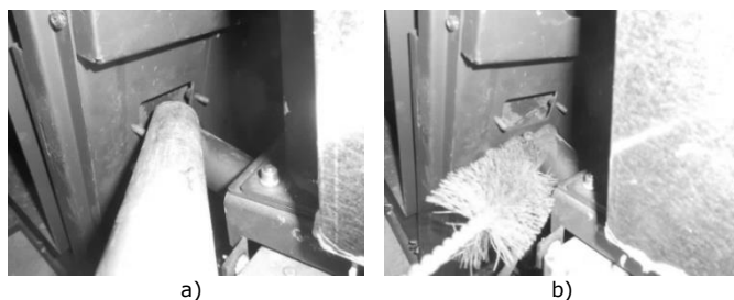
Figura 109 - a) Aspirar o interior; b) Limpeza com escovilhão
