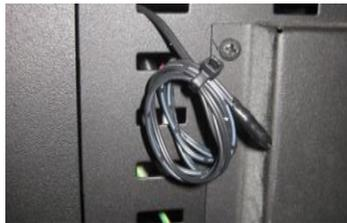
**Figure 104 – Sonde température ambiante**
