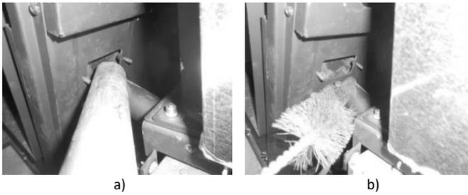
**Figure 120 – a) Aspirer l'intérieur b) Nettoyage avec brosse**
