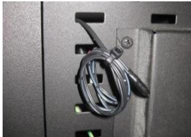
**Figura 15 - Sonda de temperatura ambiente**
